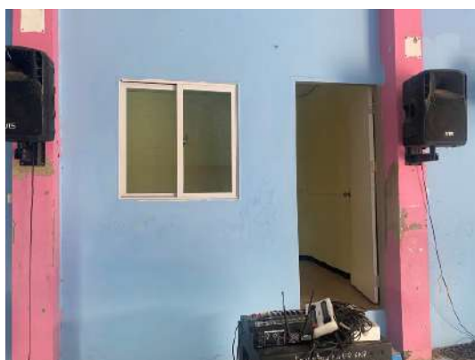
งานติดตั้งประตู - หน้าต่าง
