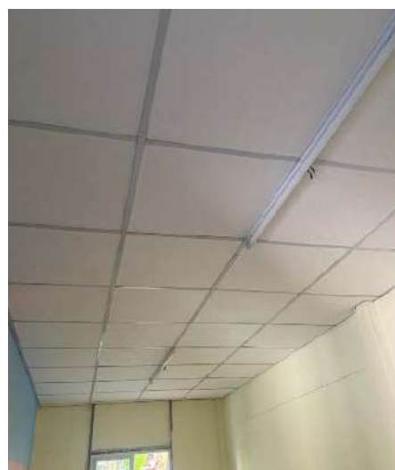
งานฝ้า-เพดาน ติดตั้งสายไฟและอุปกรณ์
